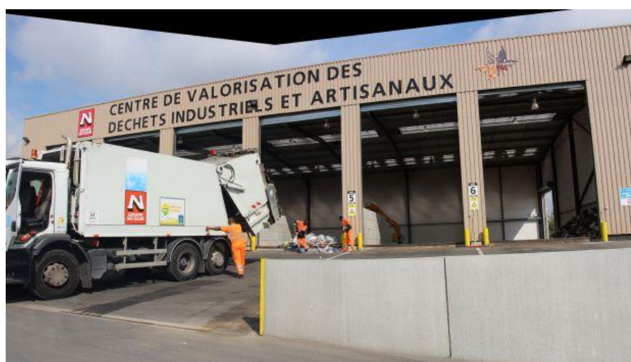
Site de transfert des déchets de Nicollin à Vigneux
